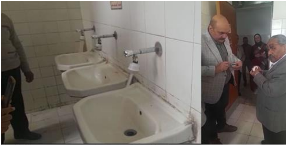
ثلاث صنابير بوصلات معدلة موفرة للمياه بدورة المياه الطلابية بالدور الثاني قسم الرياضيات صورة (4)
